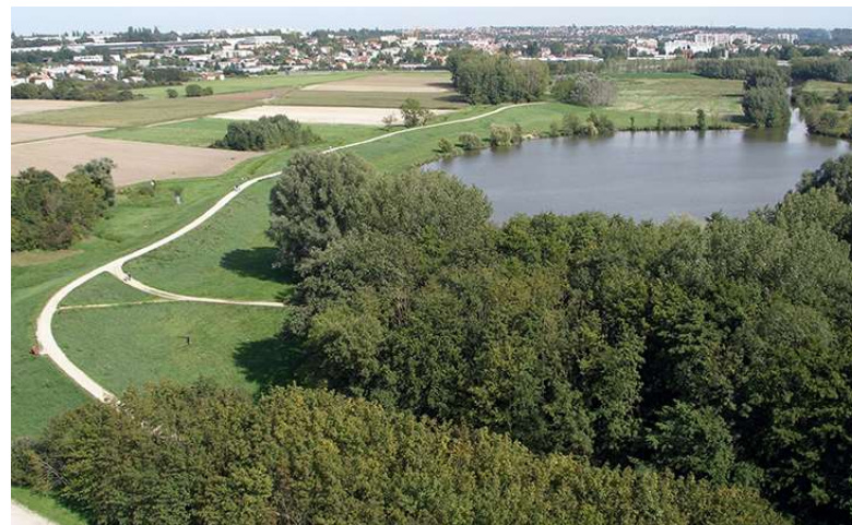
Bassin de retenue (source : Commune)
